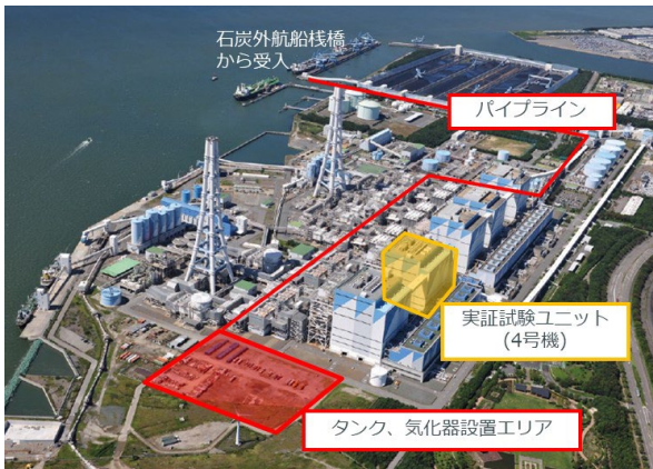
写真-1 プロジェクト① JERA 碧南火力発電所 4号機
